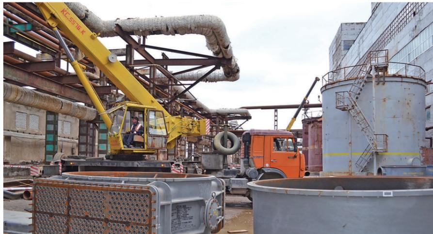
В отделении АБДСКБ № 2 выполнены врезки на абсорбционной колонне № 4 – в 15 позиций технологической схемы производства. В их числе трубопровод газа дистилляции диаметром 720 мм, трубопровод камской воды (d 273 мм), трубопровод аммиачного рассола (d 273 мм). Это позволит выполнить монтаж колонны № 4 и подключение её в работу без разгрузки производства.
