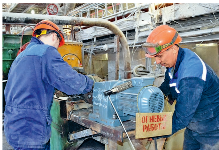
Виталий Петухов и Сергей Болотов, слесари-ремонтники РСМУ, производят центровку редуктора на привод мешалки
